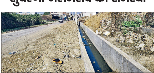
झज्जर। रहणियां कॉलोनी में जलनिकासी के लिए बनाया जा रहा नाला।
